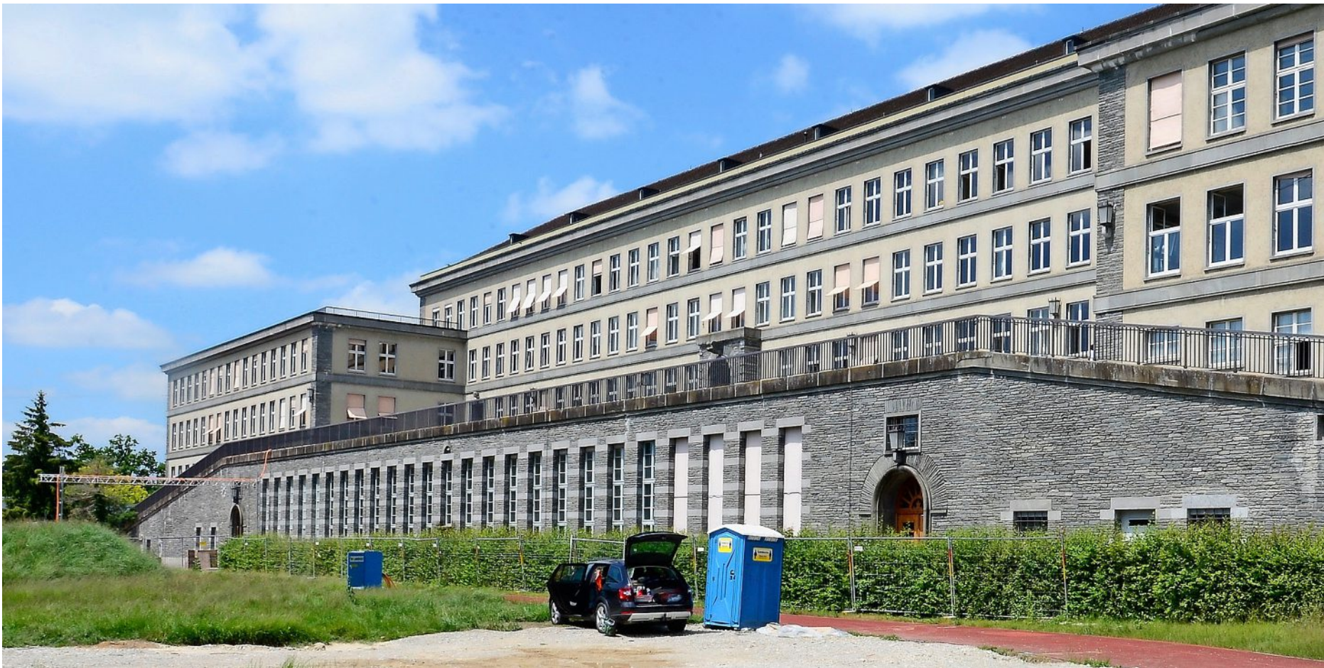
Das monumentale, denkmalgeschützte Gebäude der Kantonsschule Im Lee soll laut Planung weiterhin konventionell beheizt werden. Foto: Marc Leutenegger
